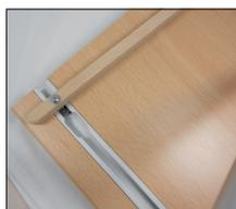
Die Abstandsleisten können durch die Öffnung an der Profilschiene entnommen bzw. hinzugefügt werden!
